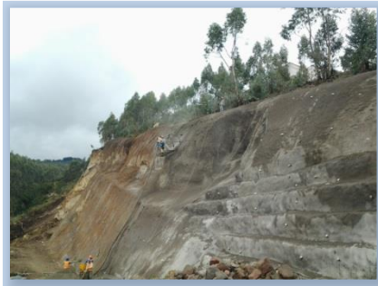
TRABAJOS DE ESTABILIZACION DE TALUDES
