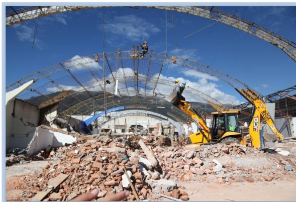
DERROCAMIENTO DE TECHOS Y ESTRUCTURAS DE HANGARES ANTIGUO AEROPUERTO DE QUITO
