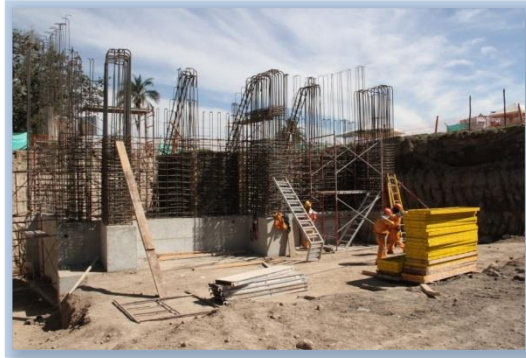
RUTA VIVA FASE II (PS8 – Sector séptima transversal)
