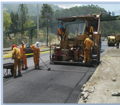
COLOCACION DE NUEVA CARPETA ASFALTICA
