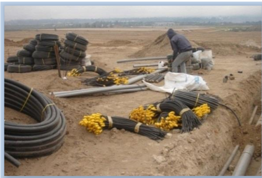
INSTALACIÓN DEL SISTEMA DE RIEGO
